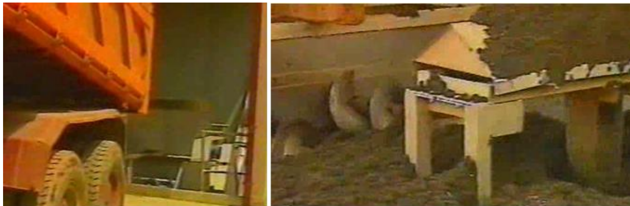
Figura 8. Stația de recepție a nămolurilor a instalației
