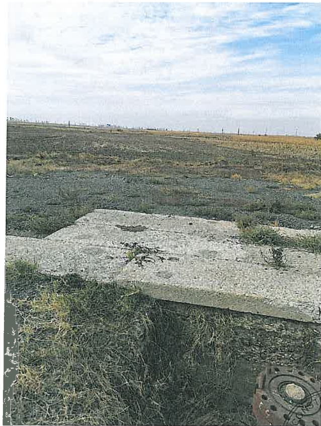
Poza 2 – Dale beton
